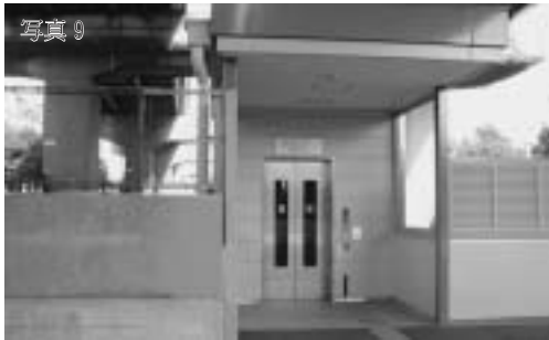
写真9 荒本駅エレベーター
